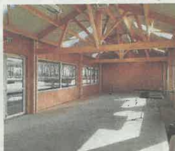
La salle de 80 m 2 , largement vitrée, du club-house permet de profiter du spectacle sur les deux carrières, à l'abri des intempéries.
